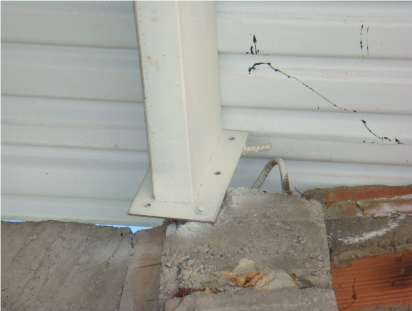
Estructura metálica de cubierta sin anclar a al estructura en concreto
