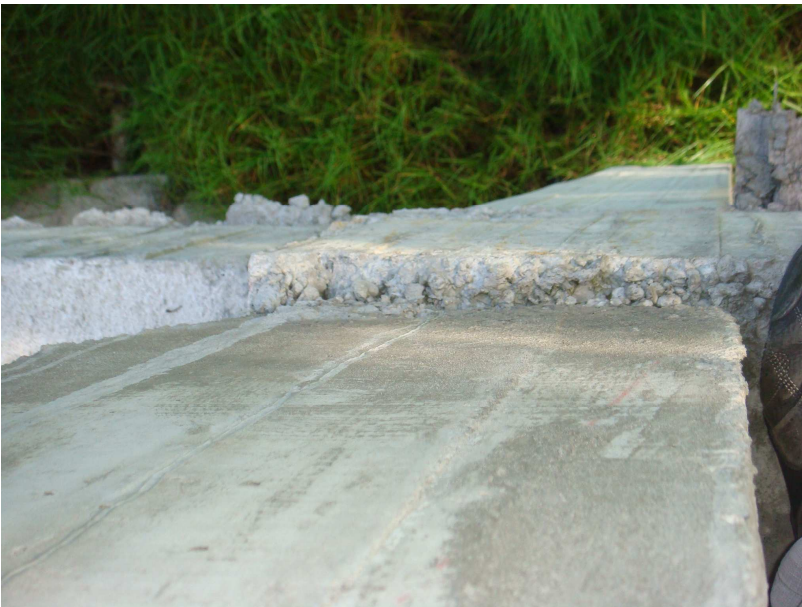
Columnas sin coincidencia con los ejes diseñados
