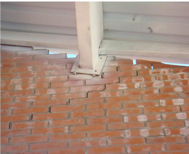
Estructura metálica inestable, soportada en mampostería fisurada
