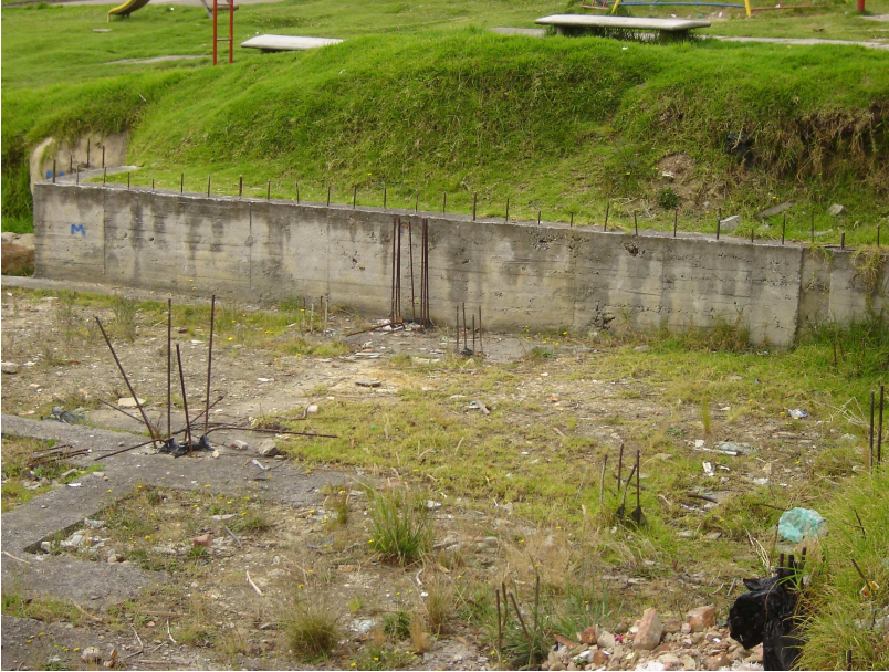
Vista muro de contención, estructura de cimentación
