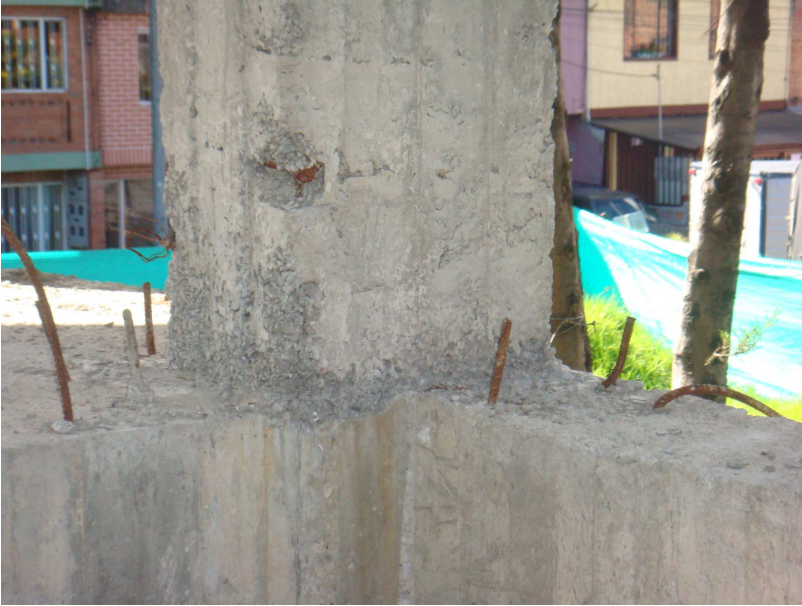
Columnas hormigonadas, refuerzos a la vista
